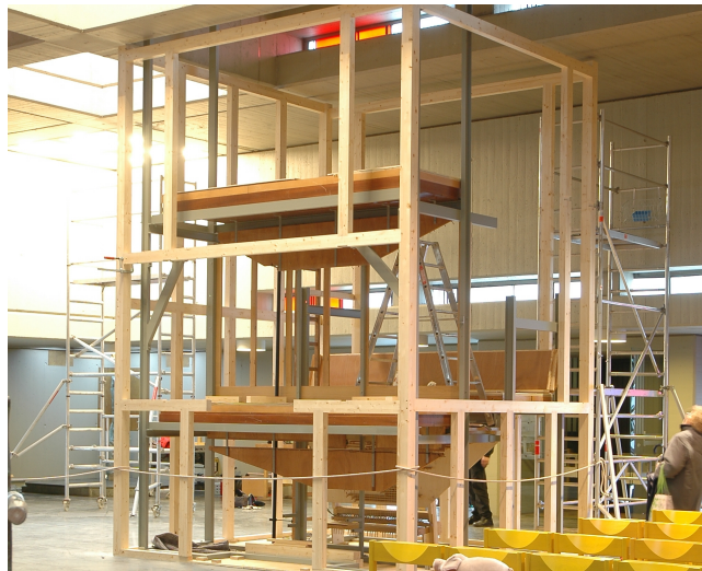
Am zweiten Tag der Montage steht das Holzgerüst des neuen Gebäuses. Hier werden später die Prospektrahmen montiert. Die Wellenbretter für die Spieltraktur sind bereits eingebaut.
