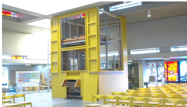
Die Gehäuseteile werden am Traggerüst montiert, der Spieltisch ist eingebaut.
