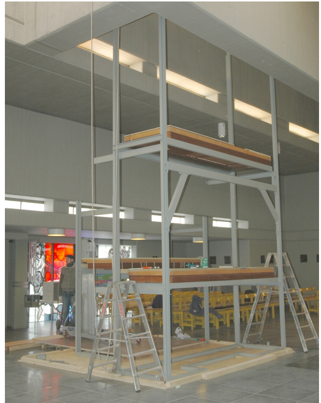
Das Stahlgerüst mit den Windladen der neuen Orgel steht bereits am Nachmittag des ersten Montagtages.
